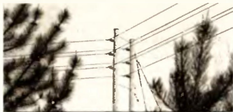
Рис. 13.38. ВЛЗ напряжением 6...10 кВ — двухцепная угловая опора
