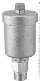
Рис. 31. Автоматический воздухоотводчик MATIC
