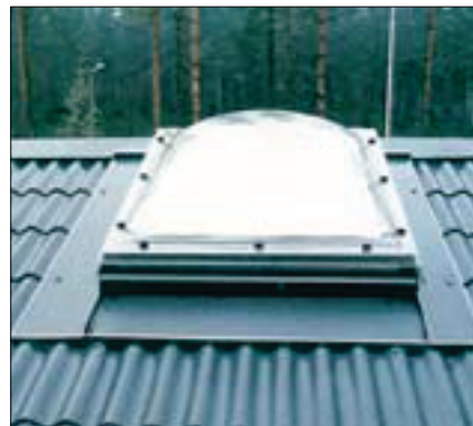
Установка светового фонаря при помощи т.н. накладного сливного фартука (см. чертежи 2 и 7)
