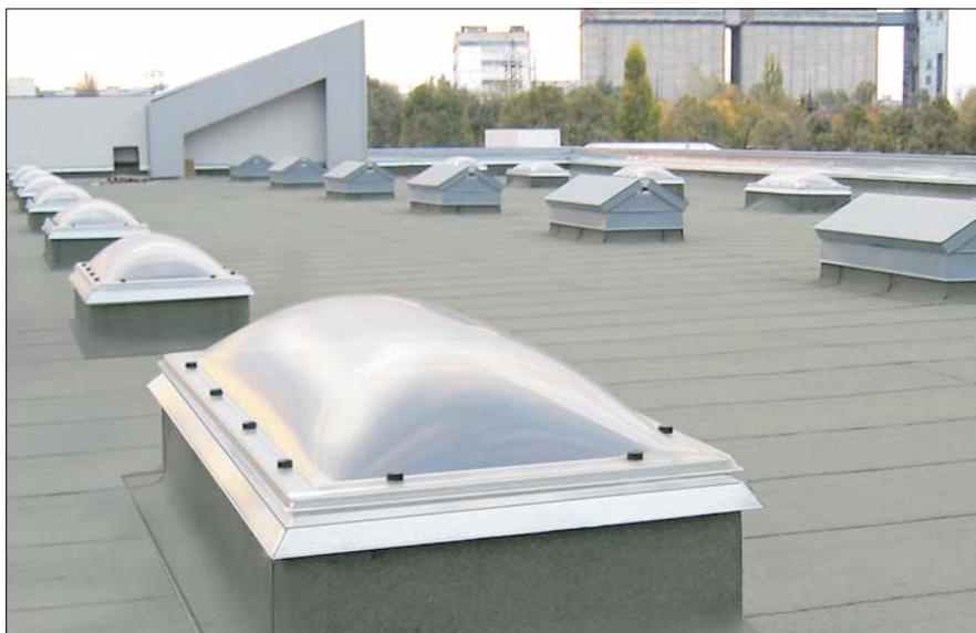
Световой фонарь типа М2N (обойная фабрика «Эдэм», г. Днепропетровск)
