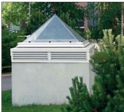
Фонарь типа PM2N (для освещения и вентиляции подземного пешеходного туннеля между зданиями Дома ветеранов в г. Лахти)
