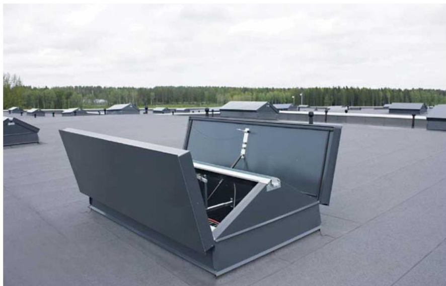
Люки дымоудаления ORI 51, терминал Transpoint, Лахти
