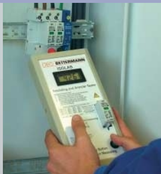
Измерение разрядников защиты от перенапряжения
