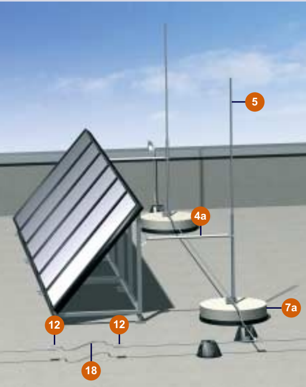
Солнечные батареи, защищенные двумя стержневыми молниеприемниками
