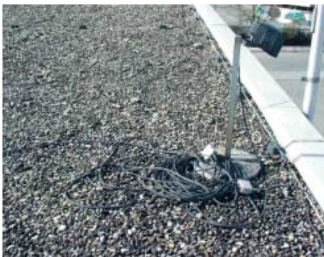
Неправильная инсталляция, наименьшее допустимое расстояние не соблюдено. Подсоединение разделительных искровых разрядников проведено неправильно, линия освещения должна быть проложена в области действия молниеотводной мачты.
