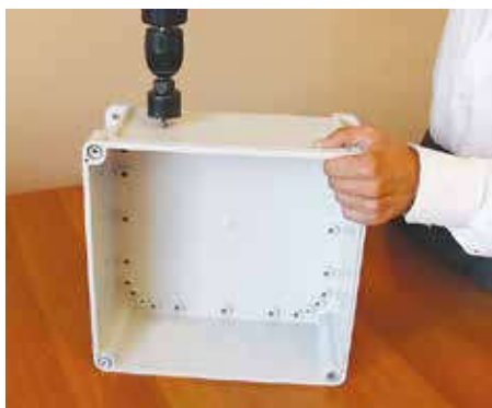
1. Просверлите отверстия
