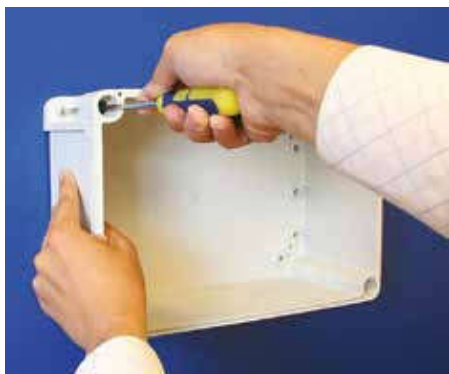
1. Прикрутите корпус к стене
