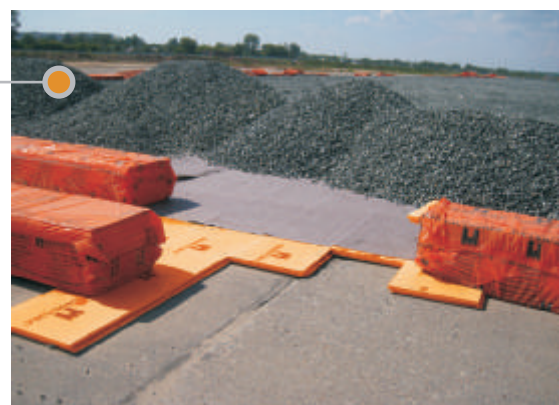
Вариант реконструкции ИВПП с одновременным уменьшением глубины промерзания грунтов
