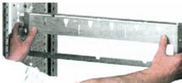
Рис. 6.4.4. Установка монтажной пластины
