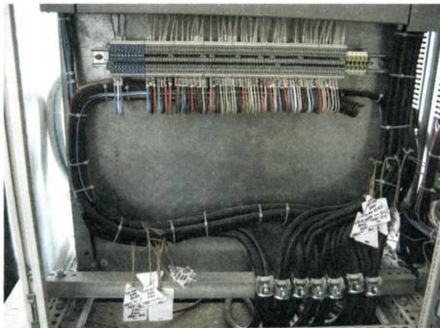
Рис. 8.1.1. Подвод контрольных кабелей снизу электроконструкции
