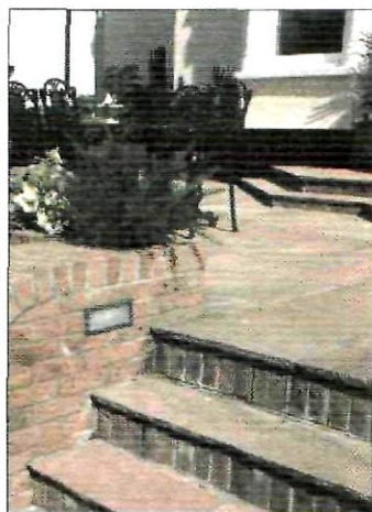
Это ступенчатое сооружение, сделанное из камня и кирпича, соединено с перилами, в которые вмонтированы светильники для освещения ступеней в темное время суток.
