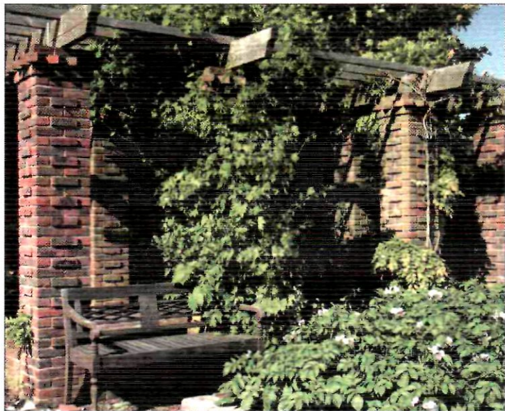
Перед вами пример традиционной английской перголы с мощными кирпичными колоннами с квадратным сечением, поверх которых пущены дубовые балки.
