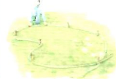
Разметить фигуру неправильной формы вам помогут веревка, шланг или цепь и колышки.
